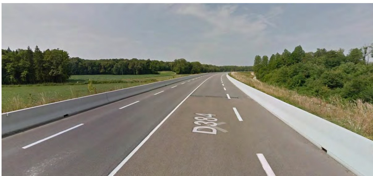
Figure 41 : Muret le long de la déviation d'Eclaron
