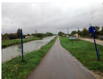
Piste cyclable le long du canal de la Marné à la Saône, en direction de Vitry-le-François, entre Perthes et Sapignicourt
