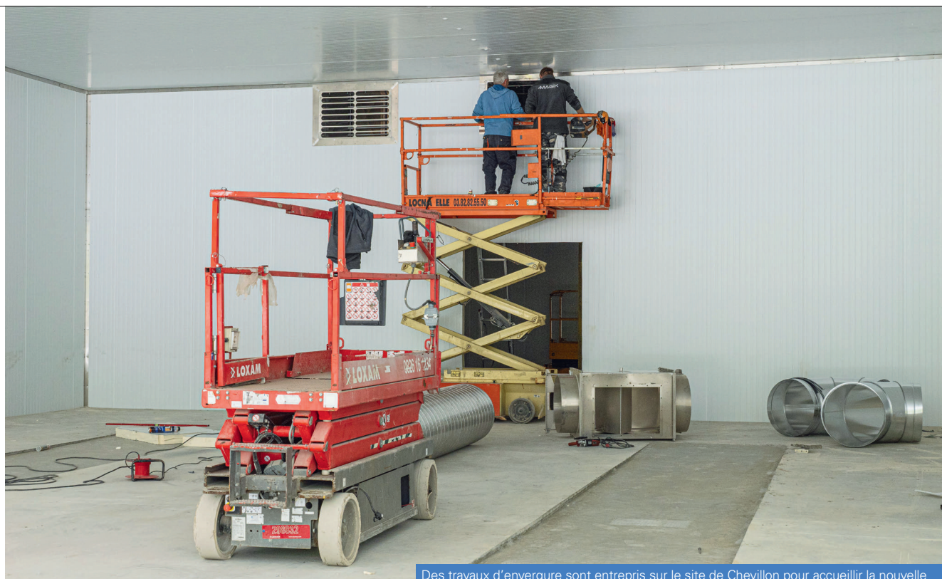
Des travaux d'envergure sont entrepris sur le site de Chevillon pour accueillir la nouvelle production de champignons de Paris.
