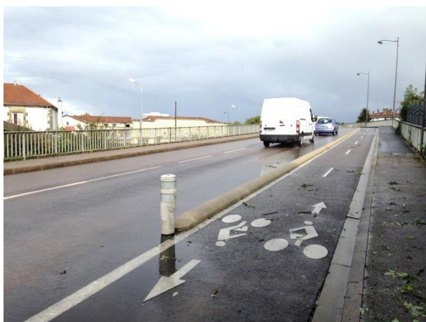
Piste cyclable sécurisée sur la rue de Verdun, au-dessous de la voie ferrée
