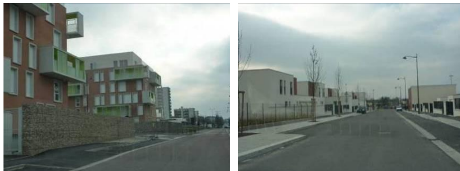
Nouvelles constructions du quartier du Vert-Bois à Saint-Dizier
