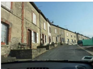
Maisons ouvrières à Brousseval
