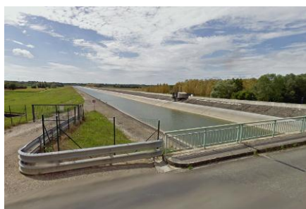
Canal d'Amenée à hauteur d'Eclaron Source : Google maps
