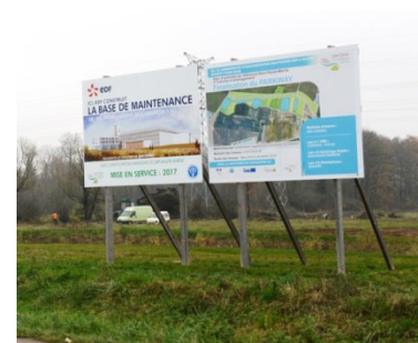
Panneau de Chantier 2 ème tranche du Parc d’Activités de Référence
