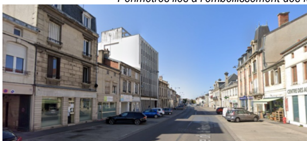
Façades avenue de la République
