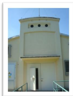
Station de production de Güe
