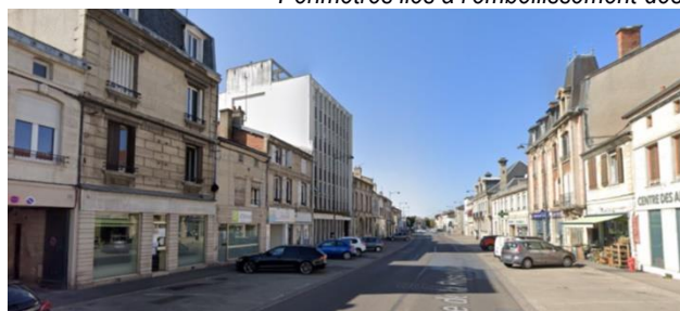
Façades avenue de la République
