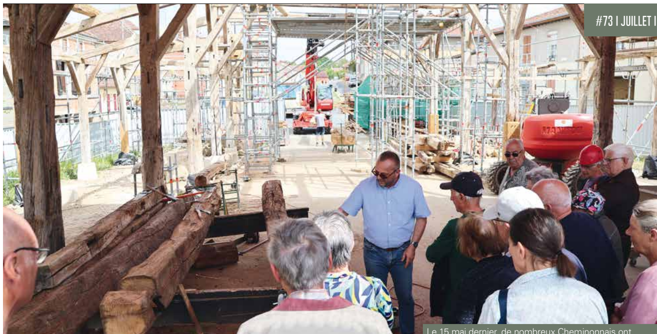
Le 15 mai dernier, de nombreux Cheminnais ont participé à la visite du chantier de la halle.
